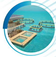
Hạ tầng nuôi biển
